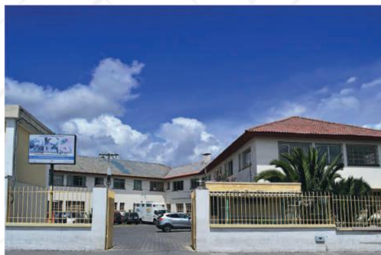
Centro de Salud #1, categorizado como Centro de Salud tipo "B", localizado en el sector sur-oeste de la ciudad de Riobamba, ocupando las antiguas instalaciones del Hospital Policlínico.
