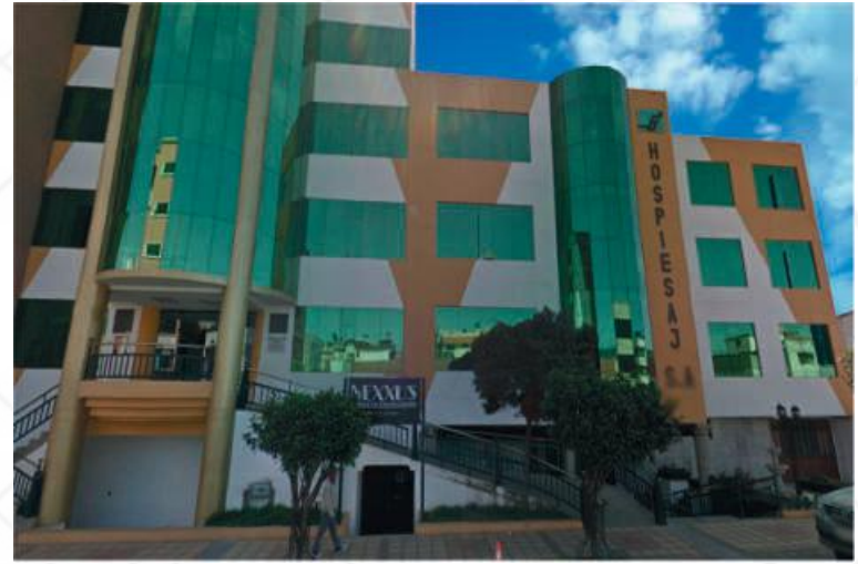
Hospital de Especialidades "San Juan" HOSPIESAJ S.A., ubicado en el norte de la ciudad de Riobamba.
